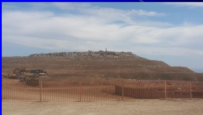
Estado actual Vertedero
